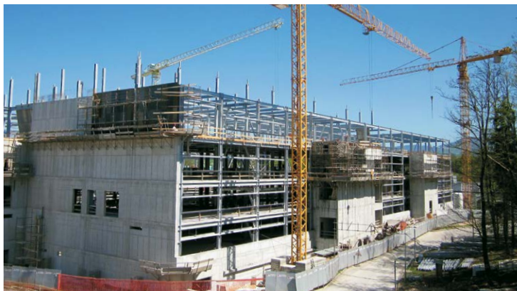
Gradnja Notola 2 je v polnem teku.
