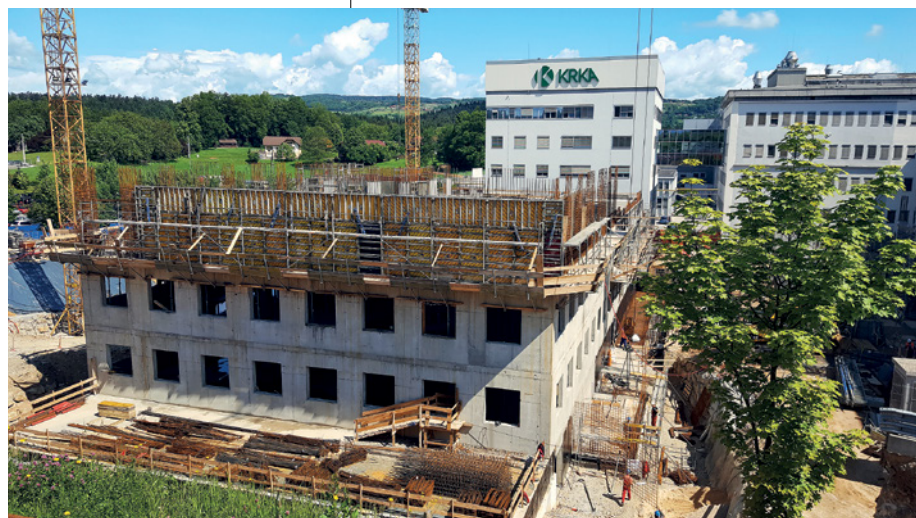
Gradnja Razvojno-kontrolnega centra 4 je v polnem teku.
