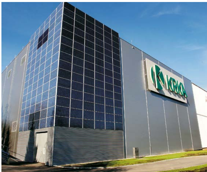
Na fasadi in strehi visoko-regalnega embalažnega skladišča smo postavili prvo sončno elektrarno.
